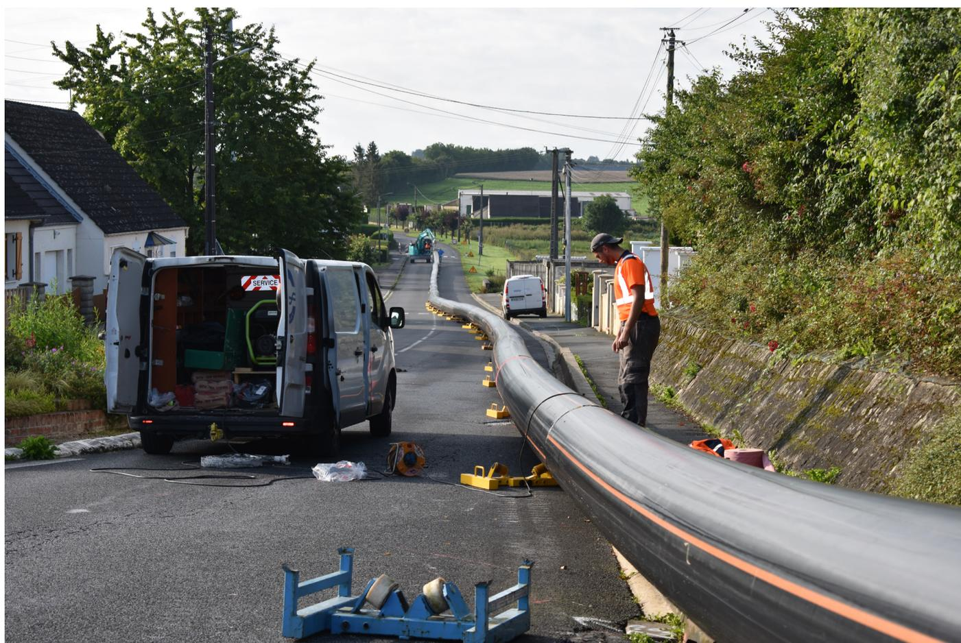
Pour lutter contre les inondations, le syndicat des eaux Noréade, a procédé au forage d'une canalisation de 9 900 m pour permettre le passage d'une conduite PVC de 650mm diamètre, pouvant ainsi rejeter les eaux pluviales.
